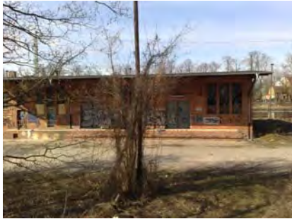
Abbildung 34: Lager, Ansicht von der Straße Unter den Ulmen
