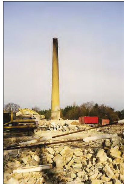
Abriß der Möbelfabrik 1999
