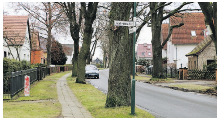
Die Sanierung des Teilstücks zwischen den beiden Einmündungen der Jacob-Wins-Straße ist für das Frühjahr vorgesehen.
