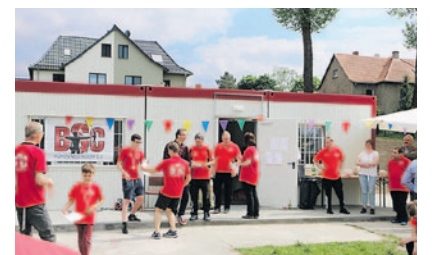
Der neue Sanitärtrakt bietet den Sportschützen Erste-Hilfe- und Umkleideraum, Teeküche und Toiletten.
