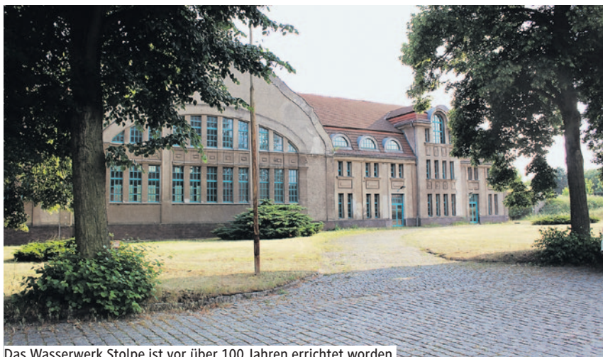
Das Wasserwerk Stolpe ist vor über 100 Jahren errichtet worden.
