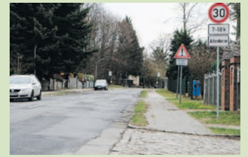
Die L171 in Bergfelde wird ab diesem Jahr saniert.
