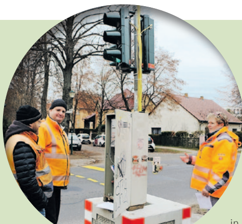
Tiefbaumitarbeiterin Elke Pigorsch (r.) nahm die Bedarfsampel im Beisein der SILA-Service-Mitarbeiter in Betrieb.
