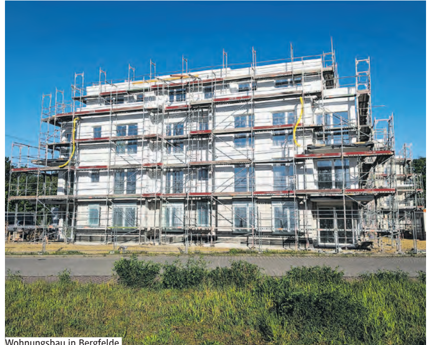
Wohnungsbau in Bergfelde.
