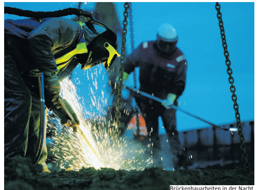
Brückenbauarbeiten in der Nacht.
