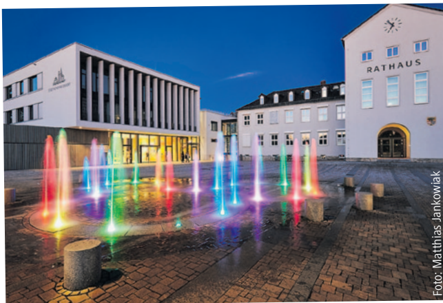
Wird trotz zahlreicher Energiesparmaßnahmen weiter in Betrieb bleiben: Das Wasserspiel vor dem Rathausplatz, das lediglich 22 Kilowattstunden am Tag verbraucht.
