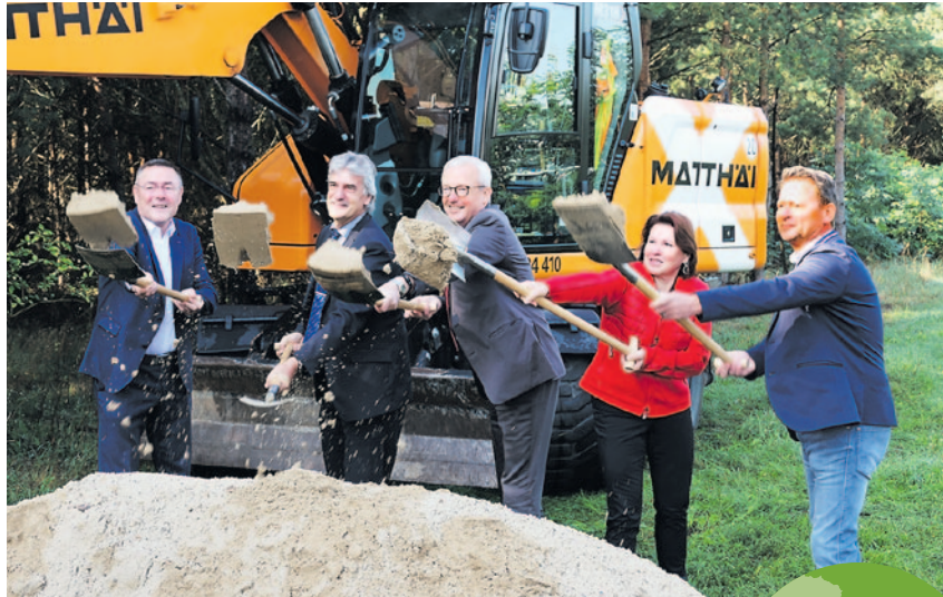
Erster Spatenstich für den Radweg von Borgsdorf nach Velten: Thomas Heyne, Egmont Hamelow, Guido Beermann, Ines Hübner und Steffen Apelt (v.l.n.r.)
