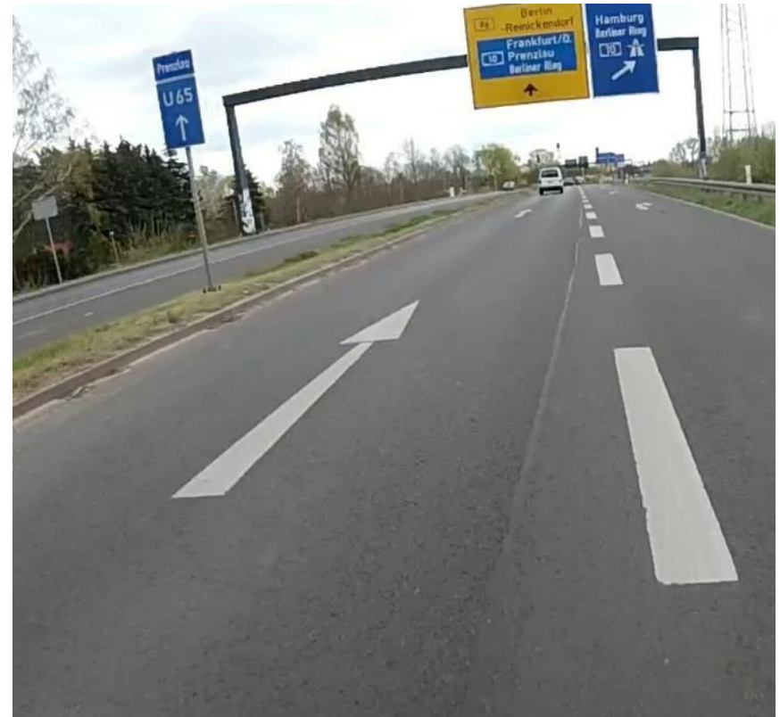
Hauptstraße Richtung Birkenwerder Zentrum: Unsichere Radfahrer dürfen auf Fußweg in Gegenrichtung fahren (KFZ 50km/h)
