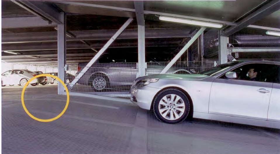
Ausgerundete Betonfertigteile im Rampenbereich bieten eine benutzerfreundliche Befahrbarkeit.
