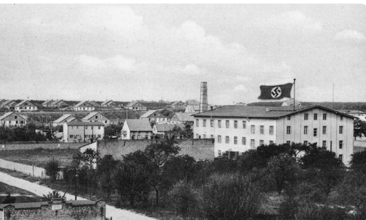
Zollschule des Reichsfinanzministeriums im Gebäude der ehemaligen Ofenfabriken H. Lehmann & Co., später Richard Blumenfeld, sowie Weststrandsiedlung, Velten
