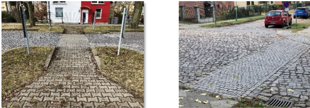
Abbildung 14: Beispiele für barrierearme Querungsfurten im Gemeindestraßennetz
